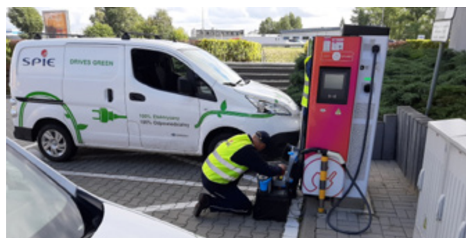
Fot. 7. Zespół serwisowy SPIE w czasie przeglądu stacji DC. Fot. SPIE.
