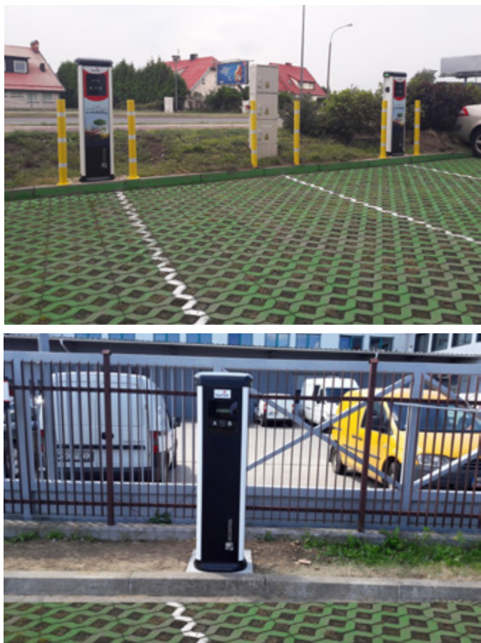
Fot. 3. Wolnostojące stacje ładowania 2x22 kW. Fot. SPIE
