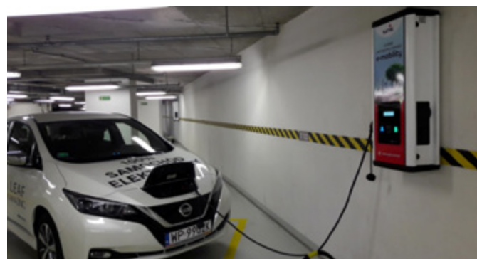
Fot. 2. Stacje ładowania Wallbox 2x22kW. Fot. SPIE.
