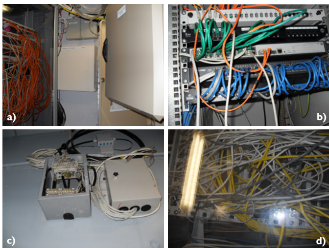
Fot. 1. Błędna realizacja punktu styku: a) punkt styku w pomieszczeniu elektrycznym (błąd projektowy); b) szafa w głównym punkcie styku w pomieszczeniu elektrycznym (błąd projektowy); c) punkt styku na drodze przejazdu w garażu podziemnym (błąd projektowy); d) chaos w głównej szafie krosowej w punkcie styku (błąd wykonawczy).
