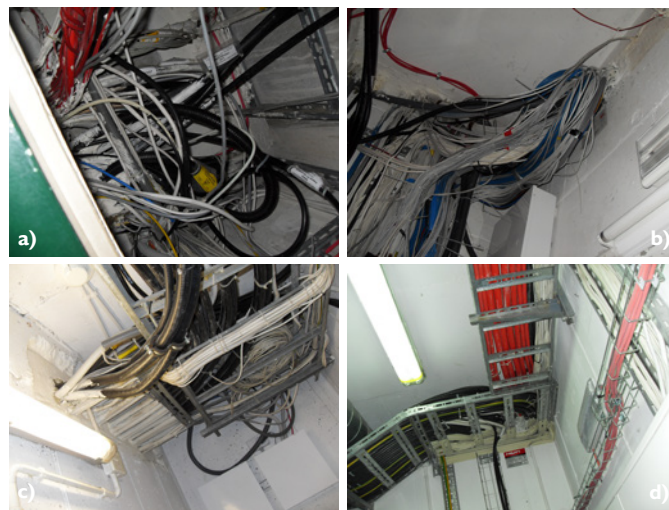
Fot. 2. Przykłady błędnego prowadzenia kabli teletechnicznych wspólnie z kablami elektrycznymi
