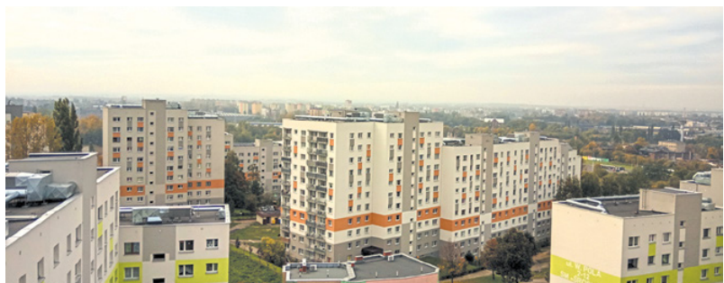
Fot. 2. Oddech dla Spółdzielni w Sosnowcu: już po termomodernizacji. Na dachach widoczne elementy instalacji wentylacyjnej
