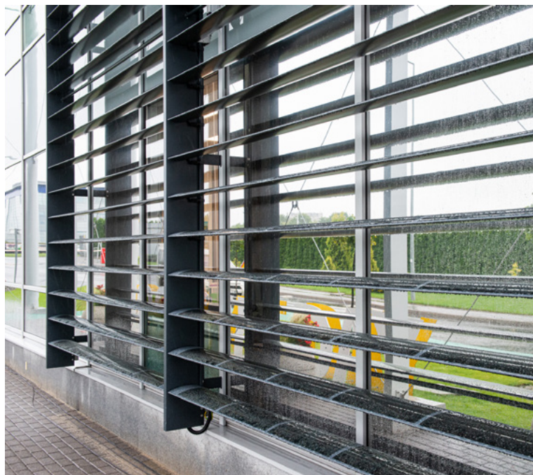
Lamele-łamacze światła na fasadzie budynku Aliplast
