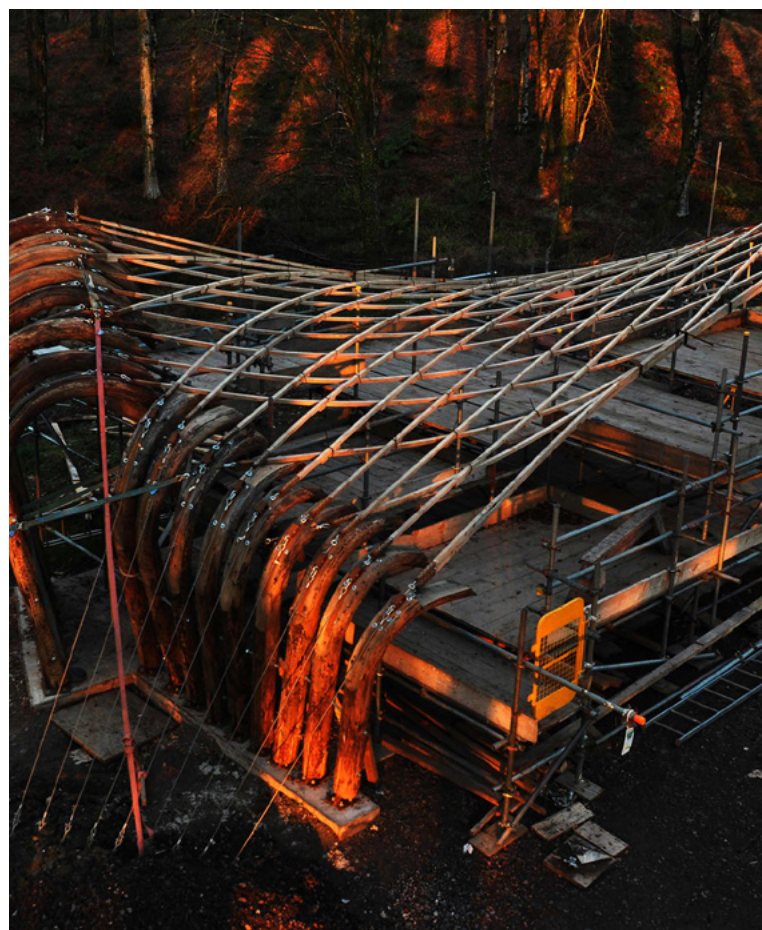
Fot. 5. Konstrukcja drewnianej wiaty Sawmill w Hooke Park
