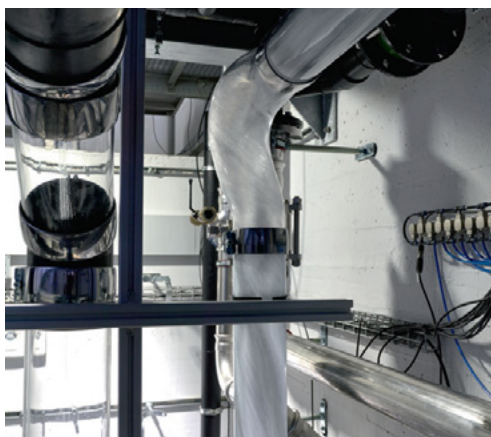
Fot. 3. Fragment wieży do badania przepływu ścieków w laboratorium Geberit
