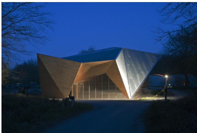
Fot. 4. Obiekt w Hooke Park, zaprojektowany przez studentów szkoły Architectural Association
