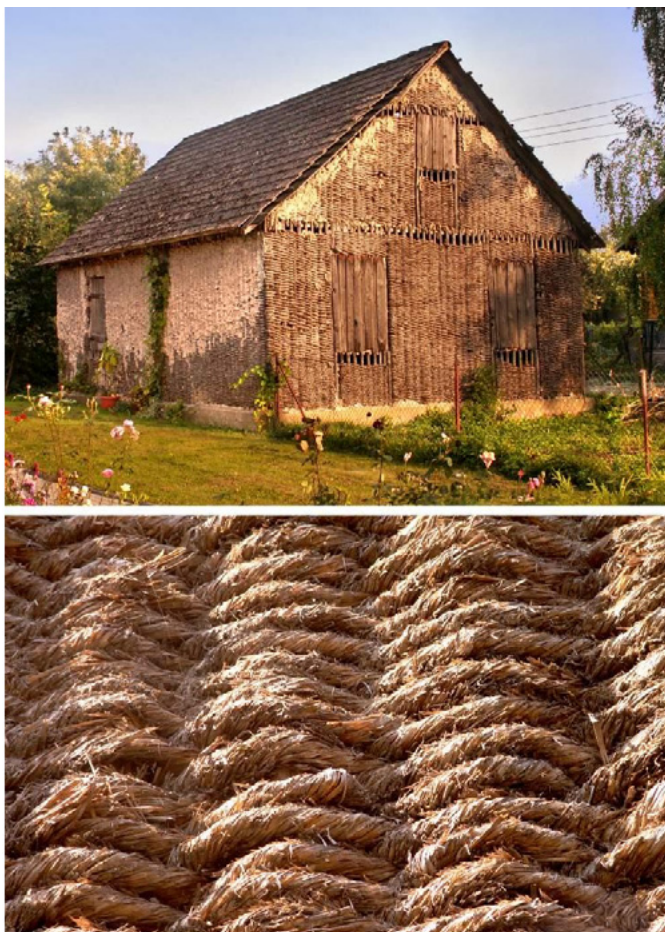
Fot. 1. Chata we wsi Rudka z wykorzystaniem plecionki jako rozwiązania konstrukcyjnego [2]
