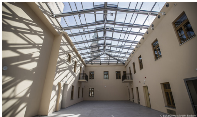
Różne aspekty kompleksowego remontu Kamienicy Deskurów: a) prace rozbiórkowe, b) dach po przebudowie, wraz z agregatami instalacji chłodniczej, c) przeszklone zadaszenie dziedzińca.
