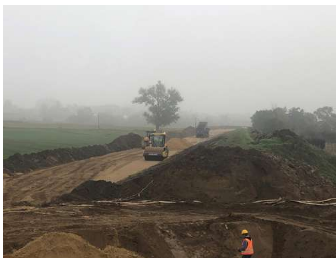
Prace ziemne – Polder Żelazna w marcu 2021 r. Fot. mapadotacji.gov.pl
