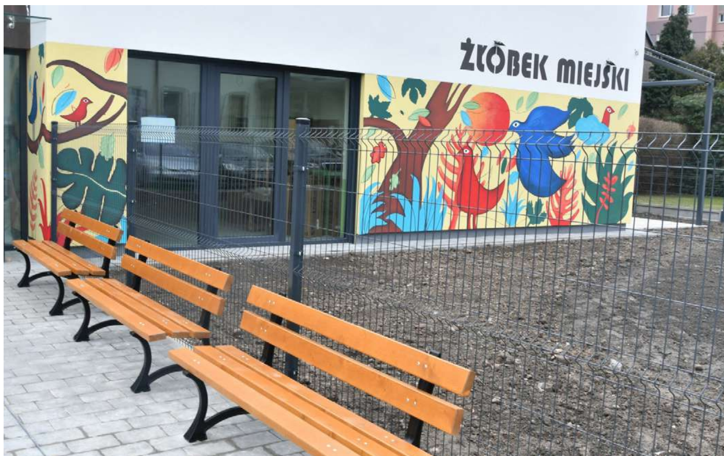
Fot. 4. Nowoczesny żłobek miejski na Ostrogu
