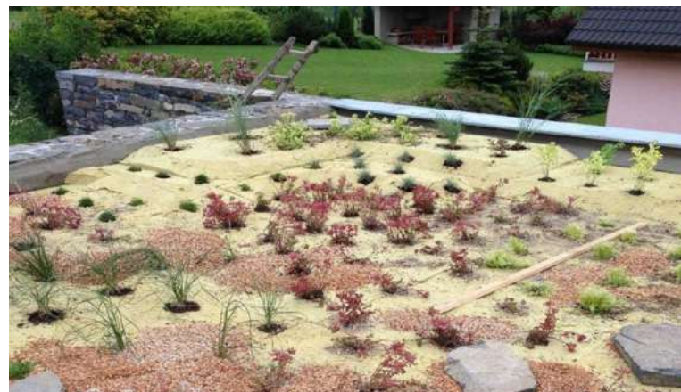
Intensywny dach zielony z zastosowaniem maty retencyjno-drenażowej SOPREFLOR RPE
