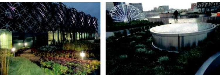
Fot. 2. Intensywne zielone dachy na Bibliotece Publicznej w Birmingham w Wielkiej Brytanii (fot. K. Kolasińska)
