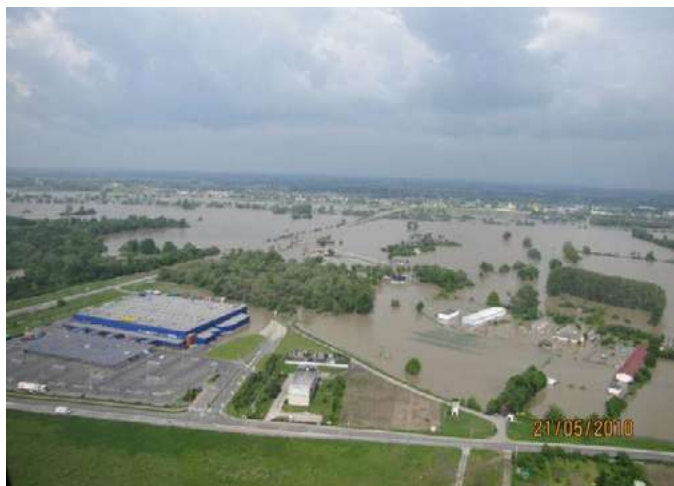
Widok na obwodnicę Opola – powódź w 2010 r. Arch. WIOŚ Opole, fot. A. Połuszczalski
