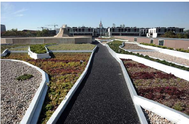
Rekreacyjny dach zielony na dachu Centrum Nauki Kopernik w Warszawie. Fot. arch. CNK
