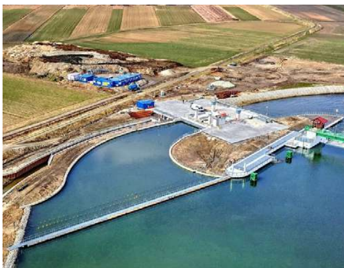
Polder Żelazna w budowie, pod koniec 2021 r. Fot. UM Opole
