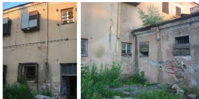
Fot. 2. Zdjęcia archiwalne (2007r.): a) fragment elewacji zachodniej, dzisiejsze wejście do Instytutu Dizajnu; b) narożnik – połączenie skrzydła wschodniego z południowym.
