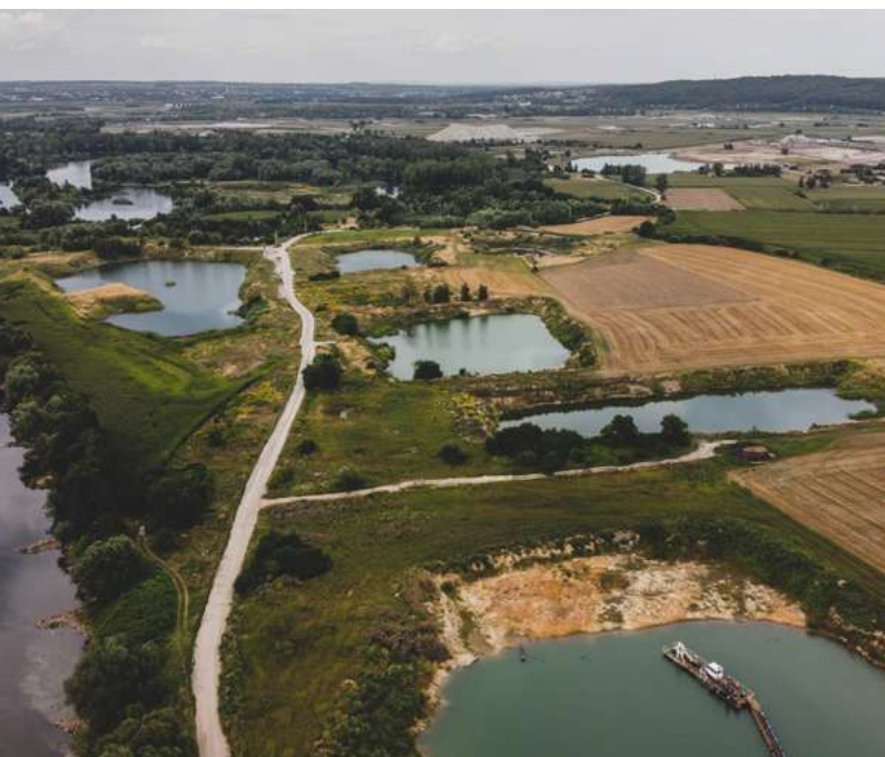
Fot. 2. Polder zalewowy Racibórz Dolny – największy obiekt hydro-techniczny w Polsce
