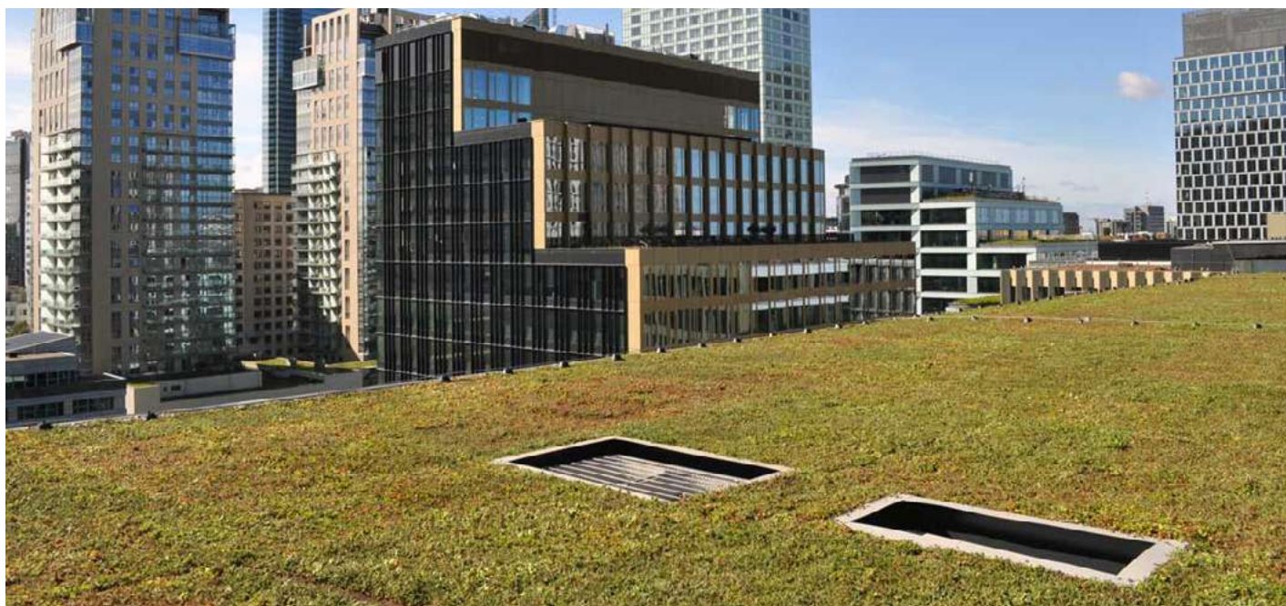
Browary Warszawskie. Dach zielony z wykorzystaniem maty retencyjno-drenażowej SOPREFLOR RPE
