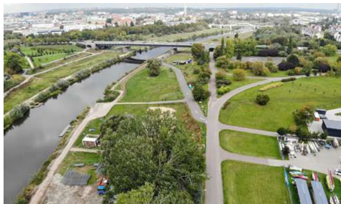
Fot. 4. Budowa Wartostrady – ciągu pieszo-rowerowego wzdłuż Warty
