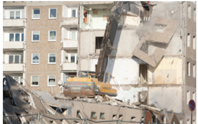
Rozbiórka budynków zbudowanych w technologii „wielkiej płyty”, z lat 70-tych XX wieku.
