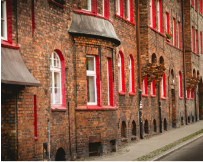
Budynki zbudowane z cegły na przełomie XIX i XX wieku.
