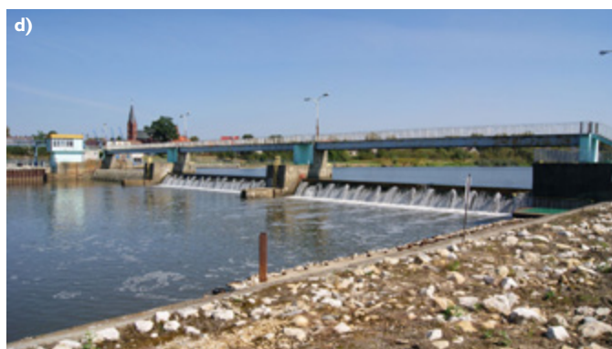
Jazy na rzece Odrze: a) przebudowany jaz we Wróblinie; b) jaz w Januszkowicach podczas modernizacji; c) jaz w Dobrzeńcu przed modernizacją; d) jaz w Groszowicach przed przebudową. Fot. Wody Polskie
