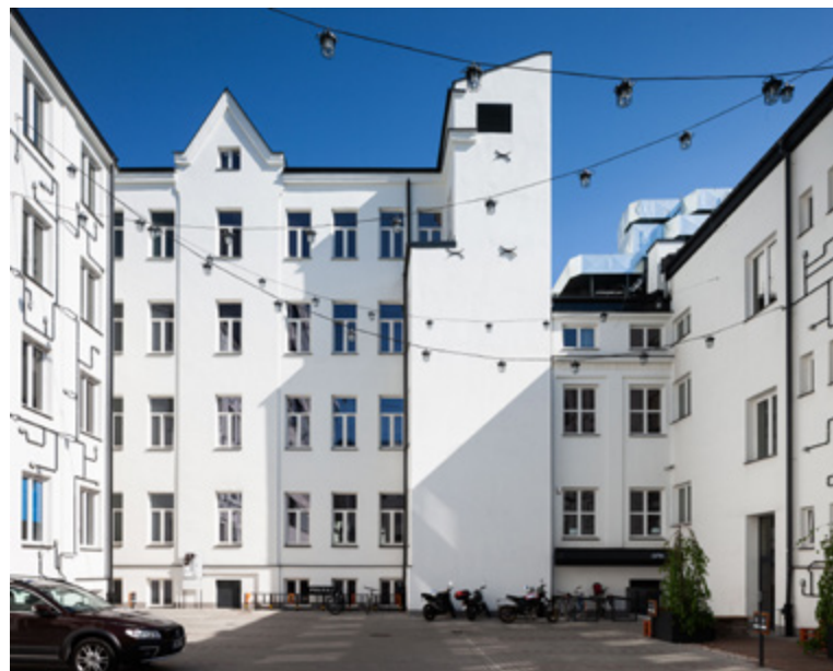
Dziedziniec kompleksu budynków przy ul. Grochowskiej 306/308 (Praga 306) w Warszawie – w procesie modernizacji budynku fabrycznego zachowano oryginalne struktury, odtwarzając historyczny rozwój budynku
