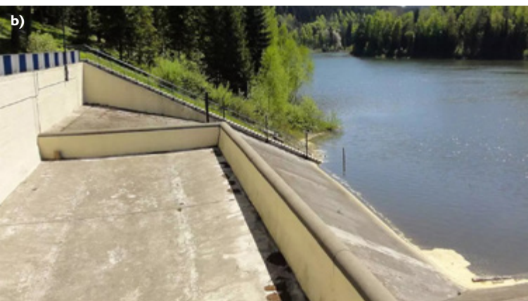
Przykładowe obiekty przewidziane do remontu: a) jaz na rzece Brynicy w pobliżu miejscowości Kup, b) retencyjny zbiornik wodny Wisła Czarne. Fot. Wody Polskie
