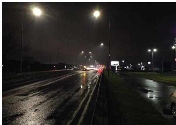
Fot. 2. Przykład niewłaściwego oświetlenia mokrej nawierzchni asfaltowej
